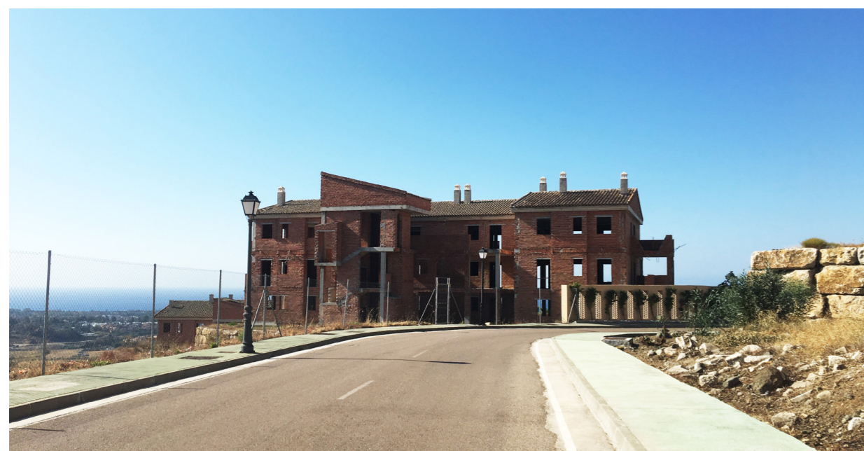
Pågående projekt Gran Vista, 24 lägenheter, Benahavis.
